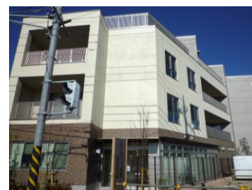
宮前地区会館「まじわーる宮前」外観
