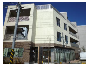
宮前地区会館「まじわーる宮前」外観
